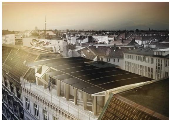
Abbildung 1: Konzept des Rooftop-Gebäudes als solarer Dachaufsatz für den Gebäudebestand (Quelle: Team Rooftop)
